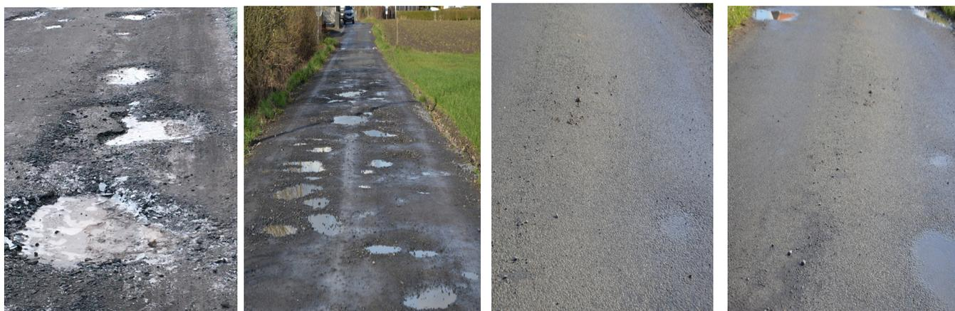
Avant et après le rebouchage des trous sur le chemin de Grohain durant la semaine du 16 au 20 janvier 2023 ; les travaux ont été réalisés par les agents techniques de la commune mais n'ont pas résisté à la vitesse et au tonnage de certains véhicules. L'objectif de fin d'année est de réaliser la rénovation totale du chemin.
