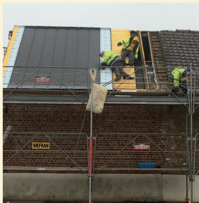
Les tuiles de la toiture sont remplacées par une couverture en zinc à joints debout. Les travaux sont réalisés par l'entreprise DELZENNE. La durée des travaux est de deux mois.
